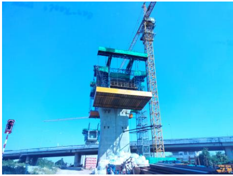
งาน Balance Cantilever Beam
